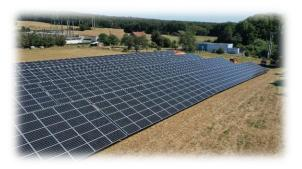
L'installation compte **1400 panneaux photovoltaïques** de fabrication européenne, montés sur une parcelle de terrain d'un hectare situé rue du Bois d'Axhelet au lieu-dit « Sur les Communes » à Andenne. Ce champ solaire produira plus de 450.000 kWh par an!
