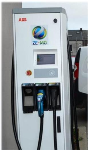
*Un supercharger 50kw DC et 44 KW AC installé à l'Andenne ARENA*
